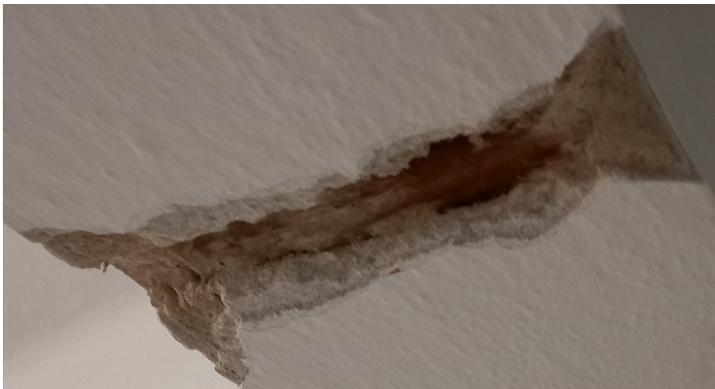
Sonda V6 – průvlak IPN400
