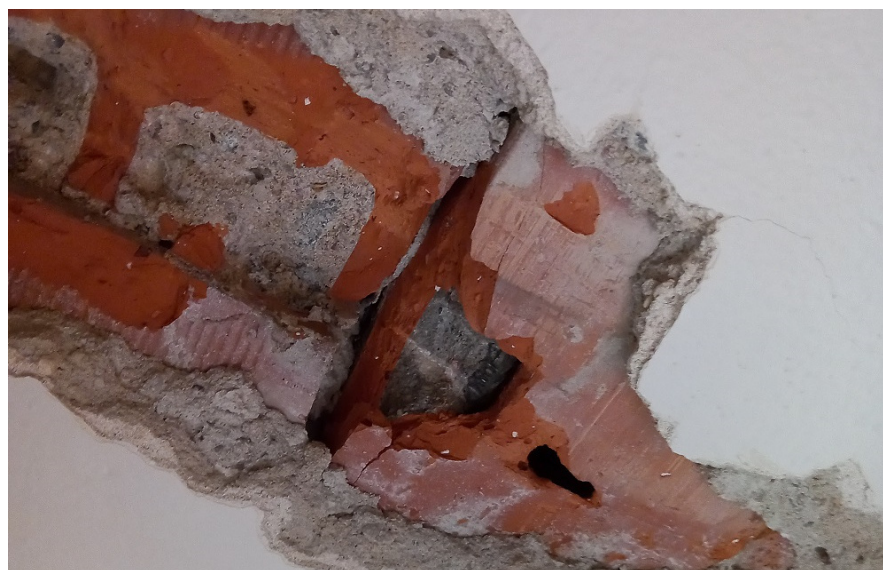
Sonda V5 – montovaný keramicko-beton. strop + podélná výztuž R10
