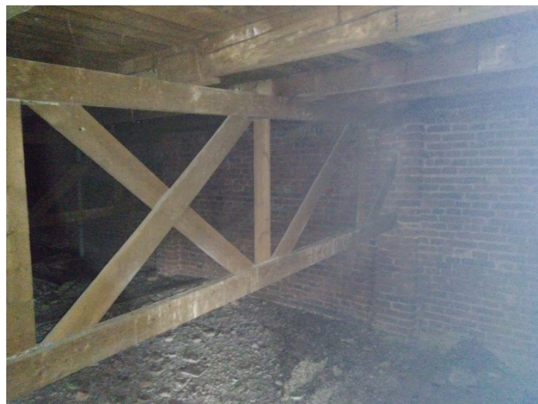
Obr. – p.s. č. 5 – zazděné uložení vazníku
