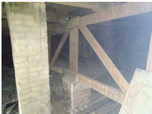
Obr. – p.s. č. 5 – uložení vazníku uprostřed rozpětí
