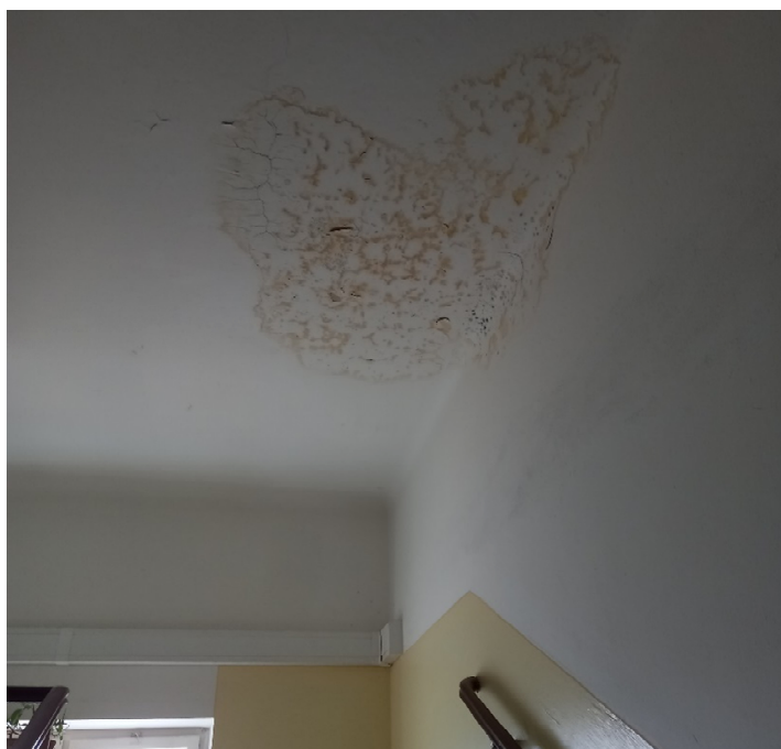
Obr. – projevy vlhkosti na interiérové omítce ve východní věži
