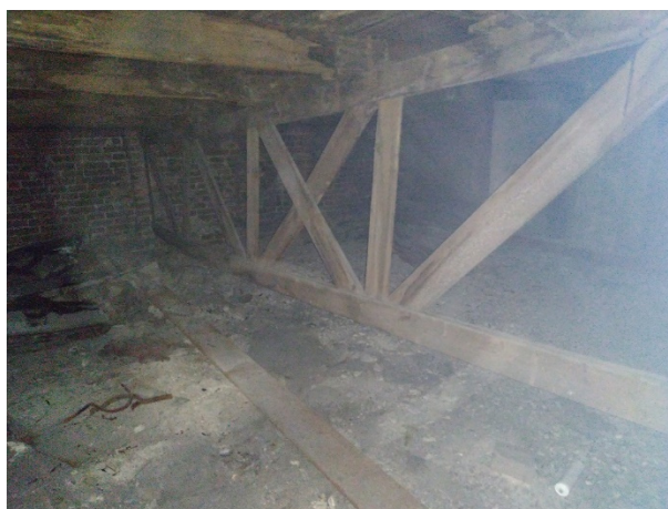
Obr. – p.s.č.5 – degradovaný vazník
