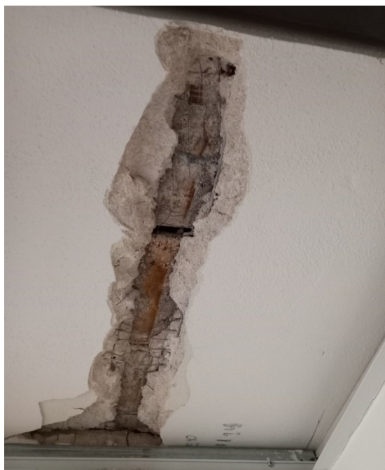
Sonda V2 – průvlak 3xIPE300
