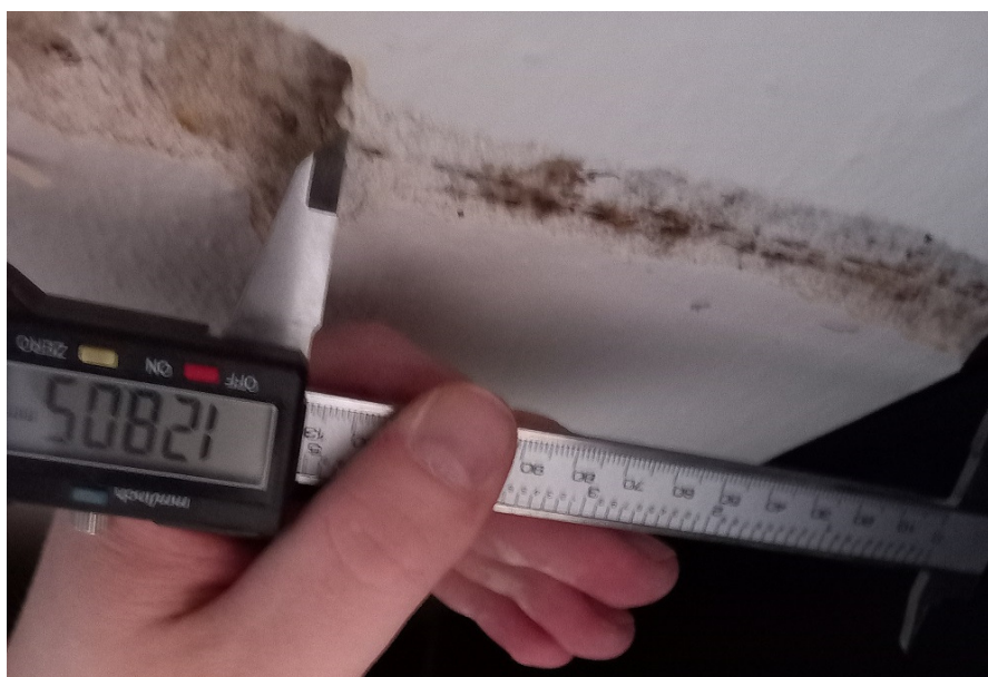
Sonda V4 – odměření spodní pásnice ocel. profilu IPN
