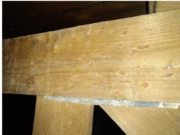
Obr. – p.s. č. 5 – degradovaný sbíjený spoj
