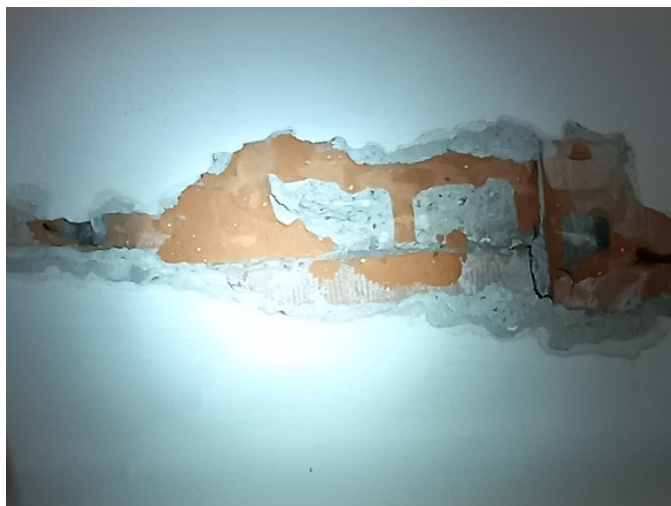
Sonda V3 – montovaný keramicko-betonový strop
