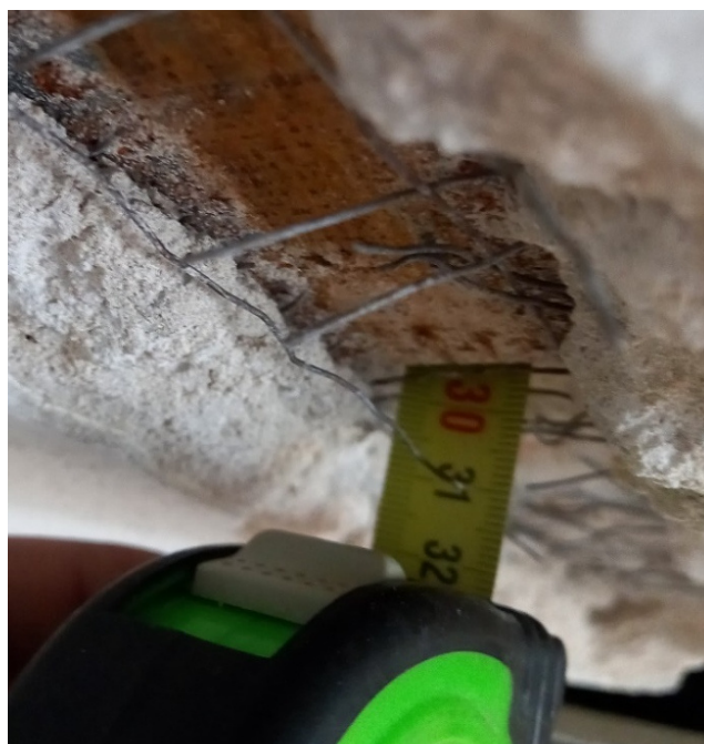
Sonda V2 – výška průvlaku
