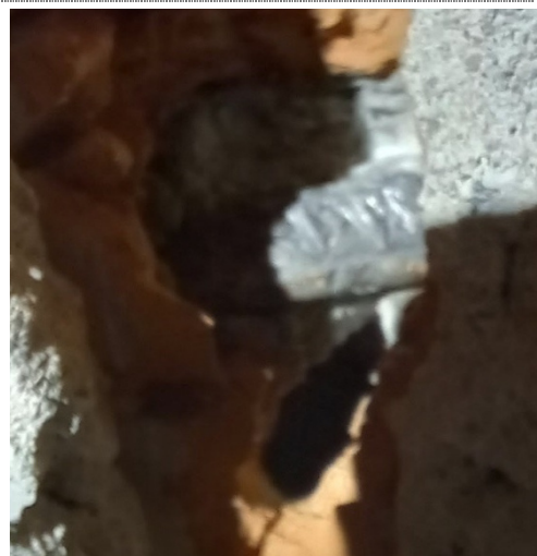
Sonda V3 – podélná výztuž R10
