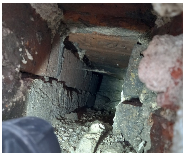
Obr. – p.s.č.6 – provětrávaná mezera
